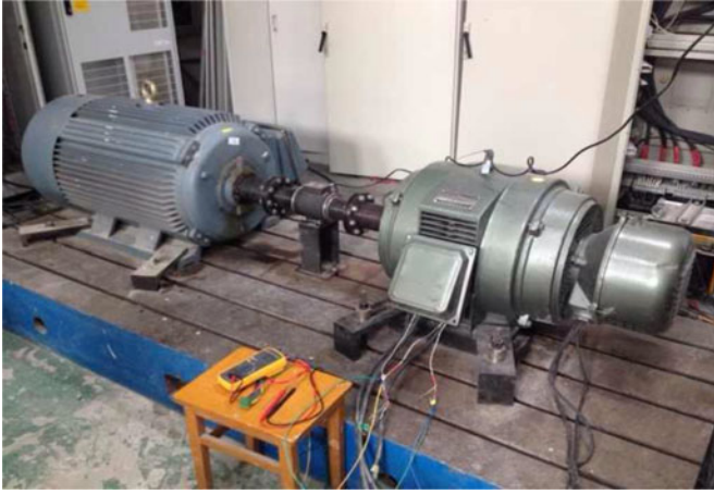
Fig. 10. DFIG machine test rig.
